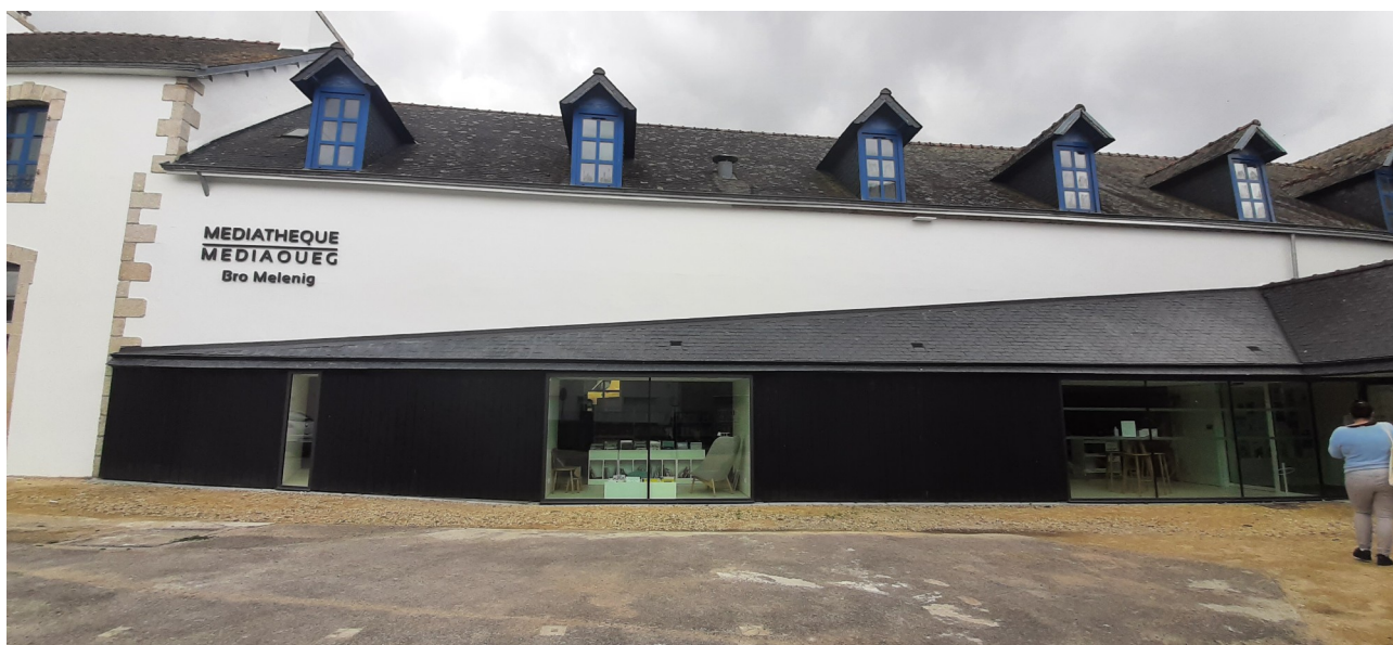
Crédit photographique : Catherine Honneur - Médiathèque d'Elliant - Entrée de la médiathèque, façade et cour.
